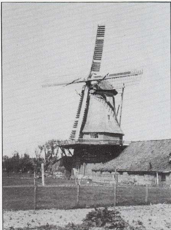
De koren- en pelmolen "De Zwaluw" te Valom in juni 1940. Let op het grote "Friese" raam boven de stelling. De molen is intussen voorzien van een giet-ijzeren as en zelfzwichting op één roede. (foto: W.O. Bakker)
