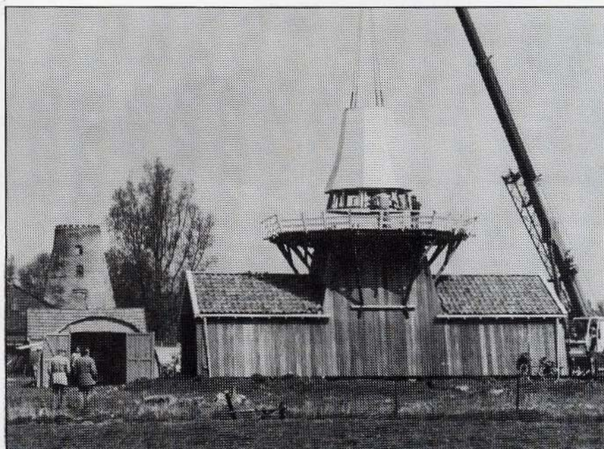
Het achtkant wordt op de zaagschuur gehesen. Links op de achtergrond de romp van "De Wille Meulen". (alle foto's van Bovenrijge: M.E. van Doornik)
