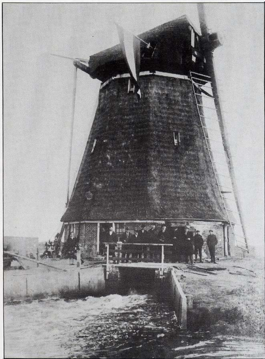
Een foto uit 1931 van de onttakelde poldermolen "Bombay" tijdens de "feestelijke" ingebruikneming van de motorische bemaling middels een 40-p.k. Kromhout-motor.
