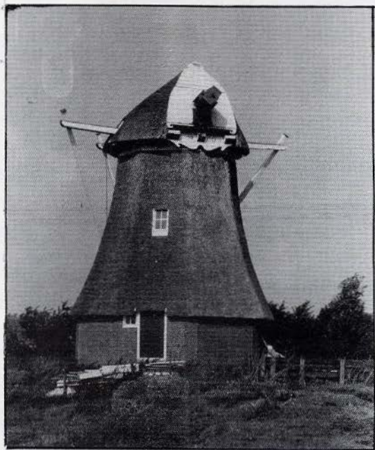
De Olinger Koloniemolen onder Appingedam met uitgenomen wieken. De roeden, een Potroede nr. 2477 uit 1921, en een Bremer-roede nr. onbekend uit 1960, zijn niet meer bruikbaar en zullen worden vervangen.
