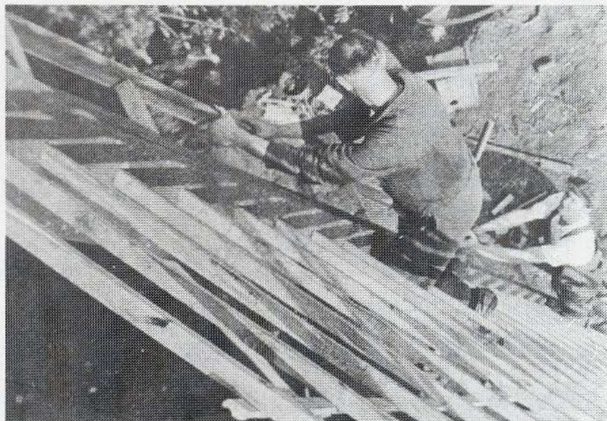
In 1936 werd de nog bestaande "Witte Molen" te Sint-Niklaas (België) verdekkerd. Op de foto zijn de mannen van roedenbouwer Verhaeghe-Decuyper te Ruddervoorde in actie aan het wiekenkruis.
