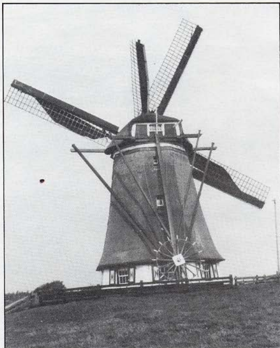
Foto hiernaast: Molen "Het Noorden" op het eiland Texel - met zijn vlucht van 27 meter de grootste poldermolen van Noord-Holland - met op de kap een afgebroken wiek. De zeilen kunnen daardoor niet geklapt worden.
