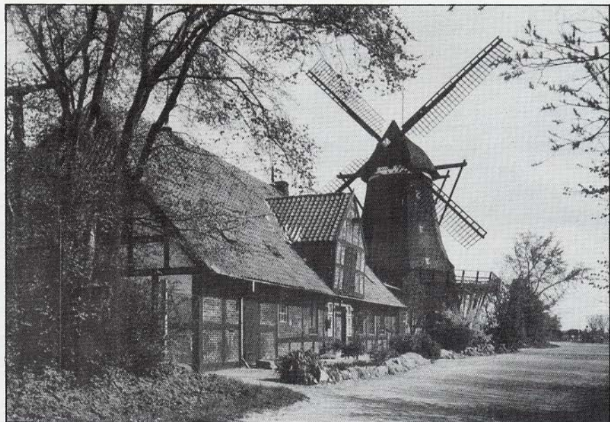
De achtkante stellingkorenmolens "Jachen Flunk" te Lemkenhafen op het Duitse Oostzee-eiland Fehmarn. Gebouwd in 1787 met een achtkantconstructie naar Hollands voorbeeld, compleet met blokkelen en neutenkruiswerk. Houten as. Het eiland behoorde vóór 1865 tot Denemarken, dus van oorsprong een Deense molen.
