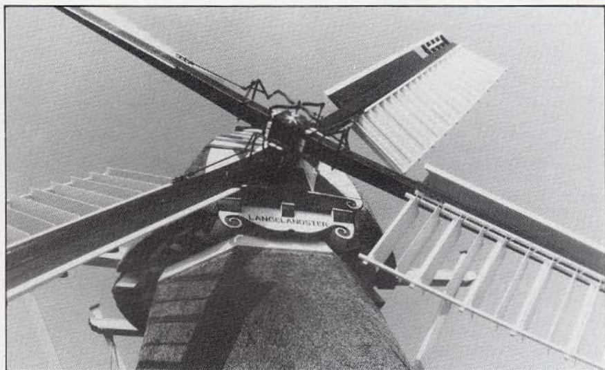
De zelfzwichting, ook soms wel jaloeziewieken genoemd, zoals hier op de "Langelandster Watermolen" te Garmerwolde, is een wieksysteem, waar wij in Groningen wel trots en zuinig op moeten zijn. Foto: M.E. van Doornik.
