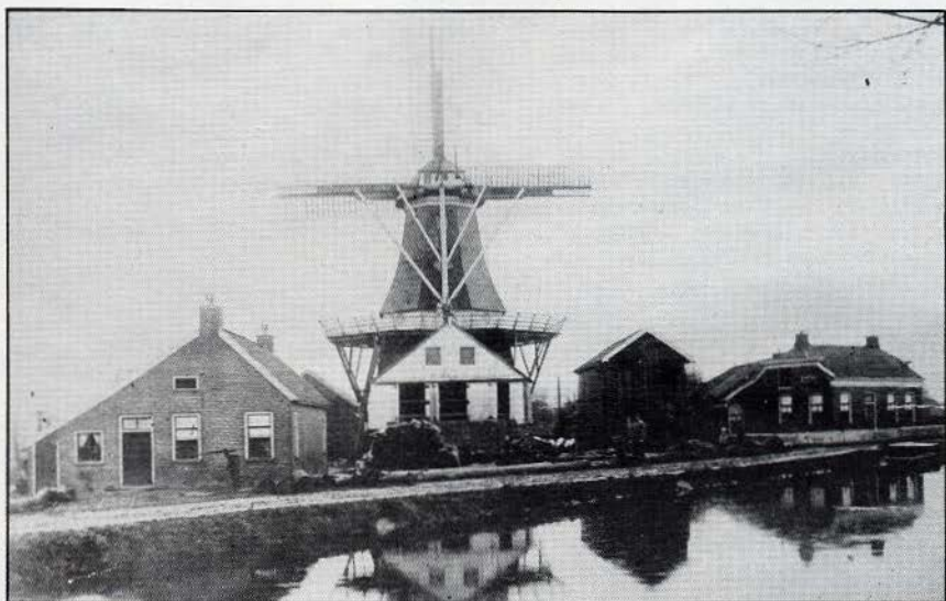
"De Vriendschap" was een achtkante stellingmolen te Eexta, gemeente Scheemda aan het Winschoterdiep met twee functies, n.l.: houtzaagmolen met drie zaag-ramen en korenmolen met twee koppels maalstenen. Gebouwd 1841, onttakeld 1920 en gesloopt 1954.
