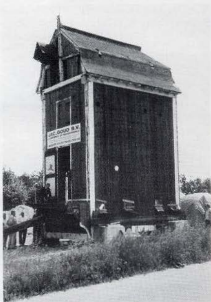
De uit Kruiningen verplaatste standerdkast wordt in Waarde weer opgebouwd. Let op de mooie Vlaamse Mansarde-kapvorm.
