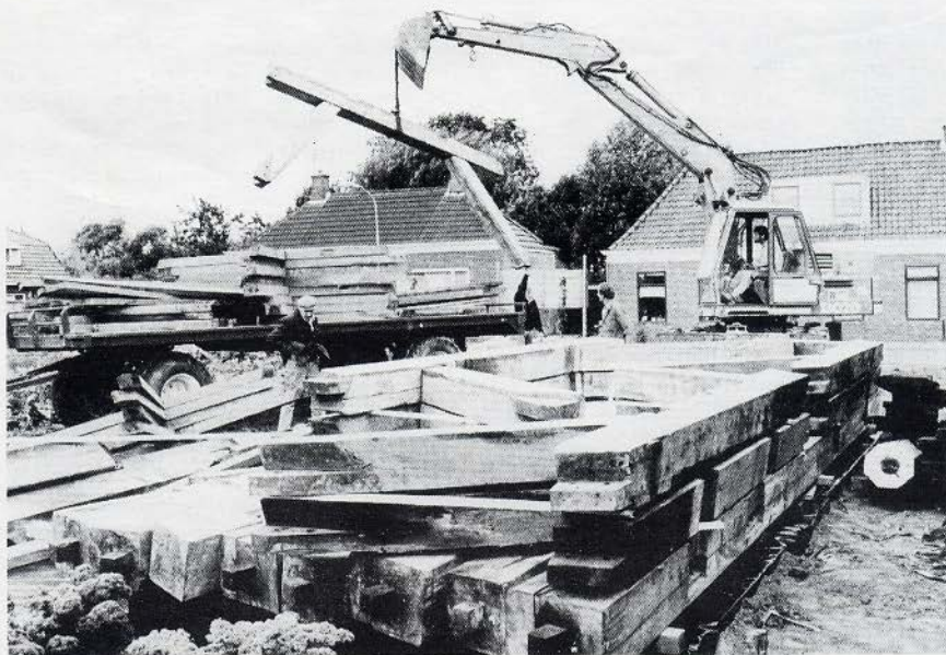
Een beeld van het uitladen van de achtkant-onderdelen in Molenrij op 14 september j.l. Na het opstapelen van de balken zal er een Romney-loods overheen worden gebouwd, die door onze Vereniging Vrienden van de Groninger Molens welwillend beschikbaar is gesteld.
