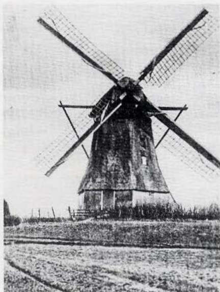
De zeskante grondzeiler-korenmolen van Blaricum in 1918. Op deze foto komt de zeskante vorm heel goed tot uitdrukking.
