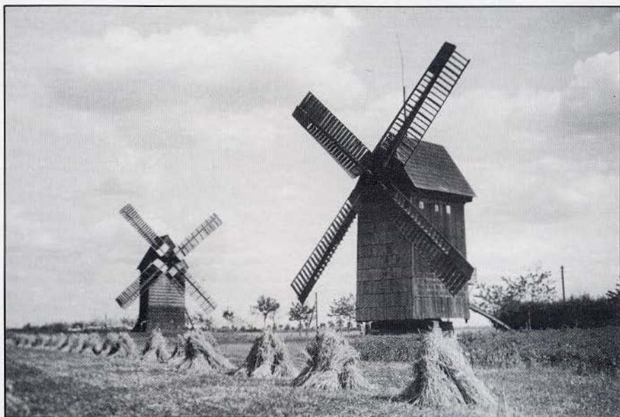
Poolse molens bij Wroclaw (het vroegere Duitse Breslau) met zelfzwichting. Soortgelijke foto's vindt men in het bij nr. 1 besproken Poolse molenboek.
