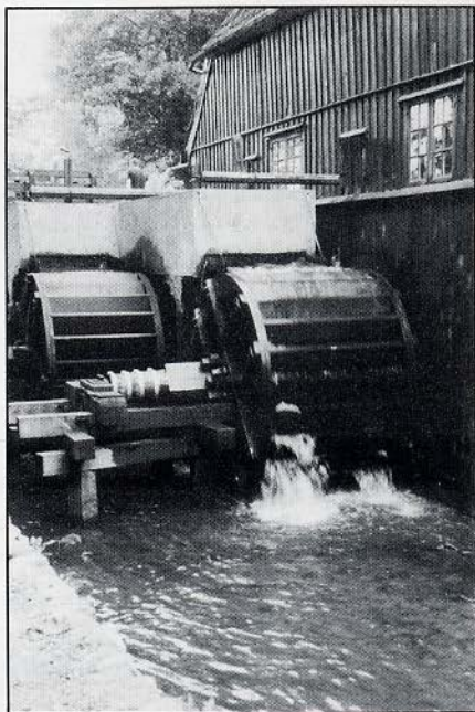
De tweerads bovenslagmolen te Børkop (Jylland) is nog volledig in bedrijf!
