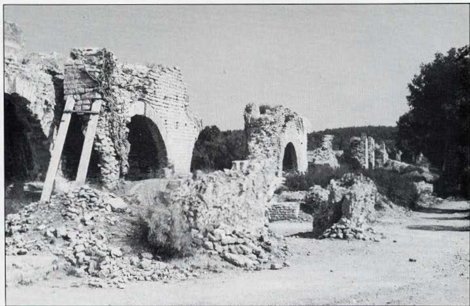
Het aquaduct van de Barbegal watermolens nabij Arles . Links richting watermolens, rechts richting samenvoeging twee leidingen.
