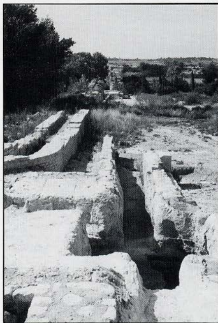
Gedeelte van de samengevoegde waterleiding, richting aquaduct (achtergrond).
