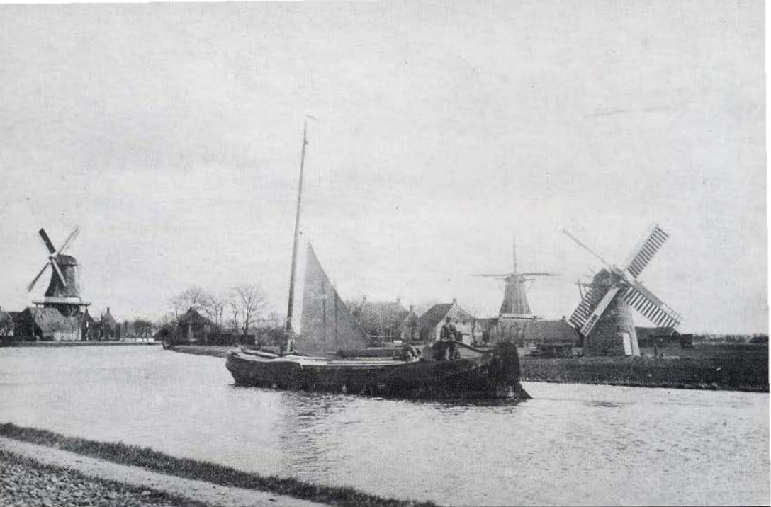
Een zeer oude foto van vóór 1900 met links de olie- en pelmolen van Abel Makken met zelfzwiching; op de achtergrond de houtzaagmolen, waar de onderste wiek juist wordt opgezeild en rechts het ronde stenen poldermolentje met zelfzwiching. Gezicht naar het oosten. Alle drie molens hebben een houten bovenas.
