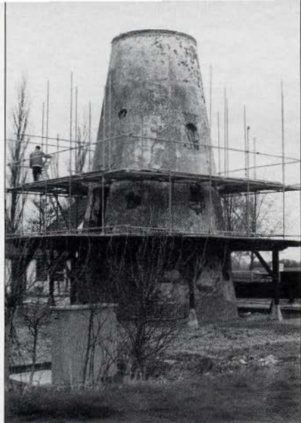
De molen "Olle Widge" te Ten Post tijdens de ingrijpende restauratie. Men is bezig de steigers om de molen te bouwen voor herstel aan het muurwerk.
