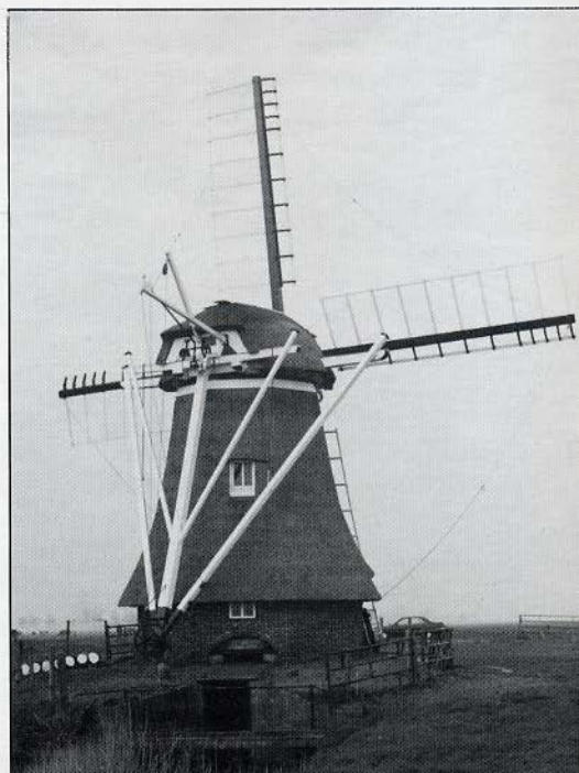
De bovenas van dit in 1960 gesloopte wipmolentje in de buurtschap Rijndijk onder Hazerswoude , zal mogelijk dienst gaan doen in de te herbouwen korenmolen "Windlust" te Molenrij . Een onderzoek met een loupe op deze foto wees uit dat het inderdaad om deze as gaat. (zie pag. 11) Collectie: H.J. Ootes.
