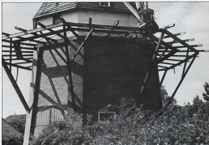
Herstelwerkzaamheden aan "De Jonge Jan" te Uithuizen.
