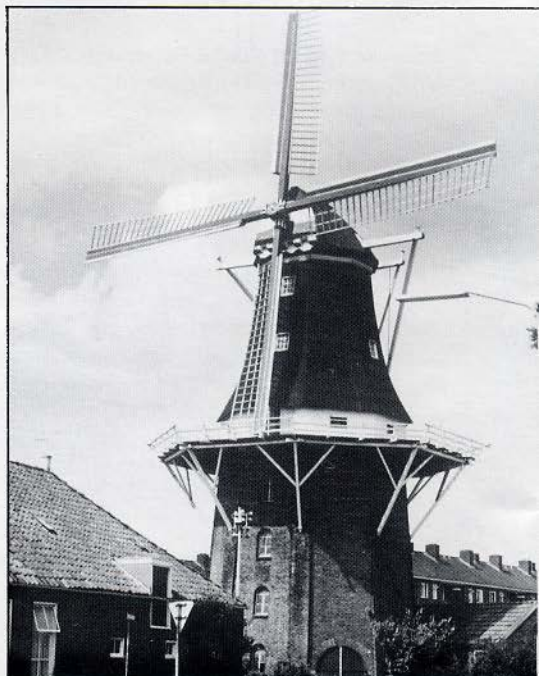
"Molen Dijkstra" te Winschoten, met onderin nog een elektromotor. Foto: P. Grund, juli 1976.
