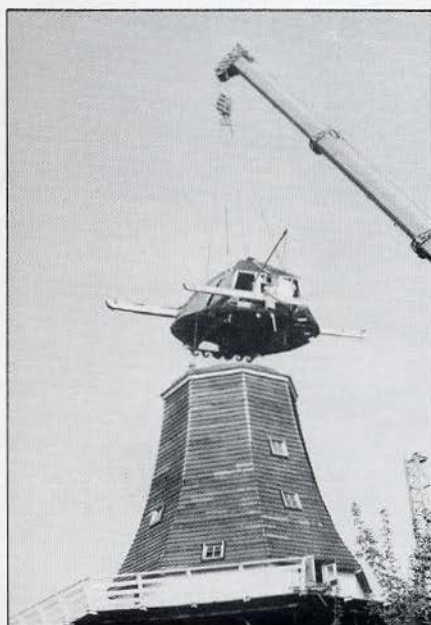
Het lichten van de kap van "De Jonge Jan" te Uithuizen ging met enig gekraak gepaard. De hijsstroppen waren om de voeghouten geslagen.
