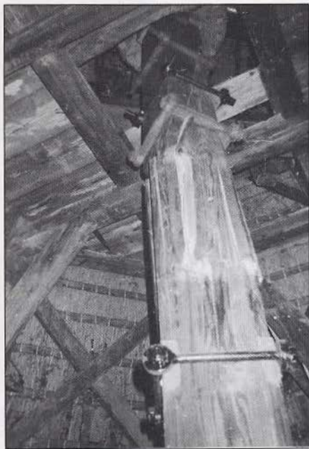
Zwaar beschadigde koningsspil van " Het Witte Lam ", gebroken onder de las. Let op de "foute" stand van de ijzeren stroppen. Foto: Marcel Duursma, januari 1993.
