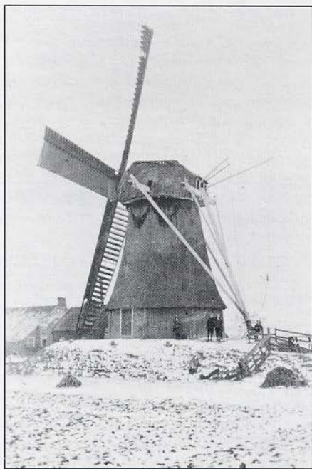
De poldermolen van de Uiterbuursterpolder, aan het Schildmeer , zw-zijde. Vlucht 76 voet, bemaalde 286 ha. land. Gebouwd in 1885 door molenmaker P. Medendorp, gesloopt begin 1938.
