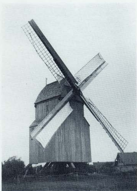
De rechtsomdraaiende standerdmolen te Oppenwehe. De kast heeft kombuizen om meer ruimte in het molenlichaam te creëren. (Foto: M.E. van Doornik, 13 juni 1993.)
