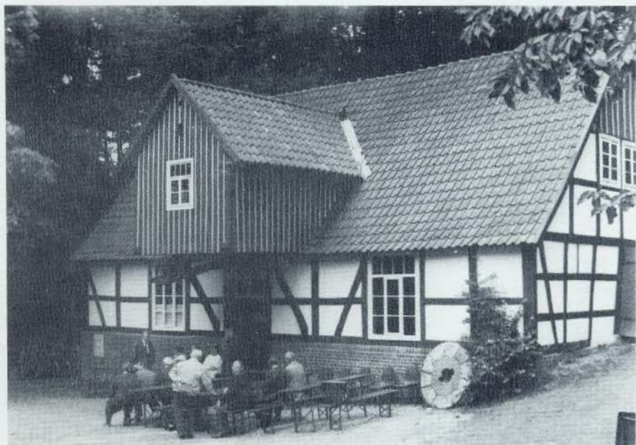
Waterradmolen te Döhren, Anno 1721. Deze molen heeft 2 koppels maalstenen met bovenliggend spoorwiel. (Foto: M. E. van Doornik, 13 juni 1993)
