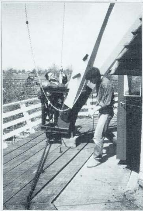
Molenaar Piet van Tongeren bezig de kleppen van de zelfzwichting dicht te trekken. Rechts van hem de heer Gerritsen (foto P. van Dijken)
