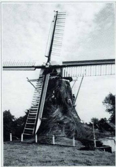
Vrijwilligers in actie om het riet van het achtkant te halen van poldermolen De Eendracht te Sebaldeburen. Naderhand werd het riet in 110 pakjes geperst. (foto: HB 8 oktober 1994)
