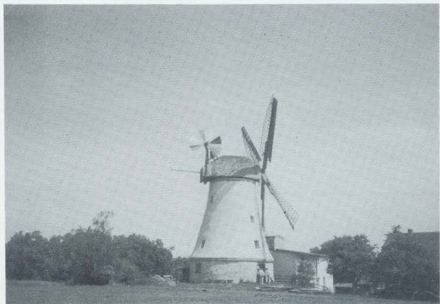
Stenen korenmolen te Lechtingen in het Osnabrücker Land, gebouwd in 1887. Gerestaureerd in 1982-87. De roeden zijn zo kort dat men de zeilen alleen met behulp van een trap kan voorleggen. Oorspronkelijk had de molen zelfzwichting maar dat werd niet meer aangebracht. (foto: Willem Roose, Gouda. Coll. CEvdH)
