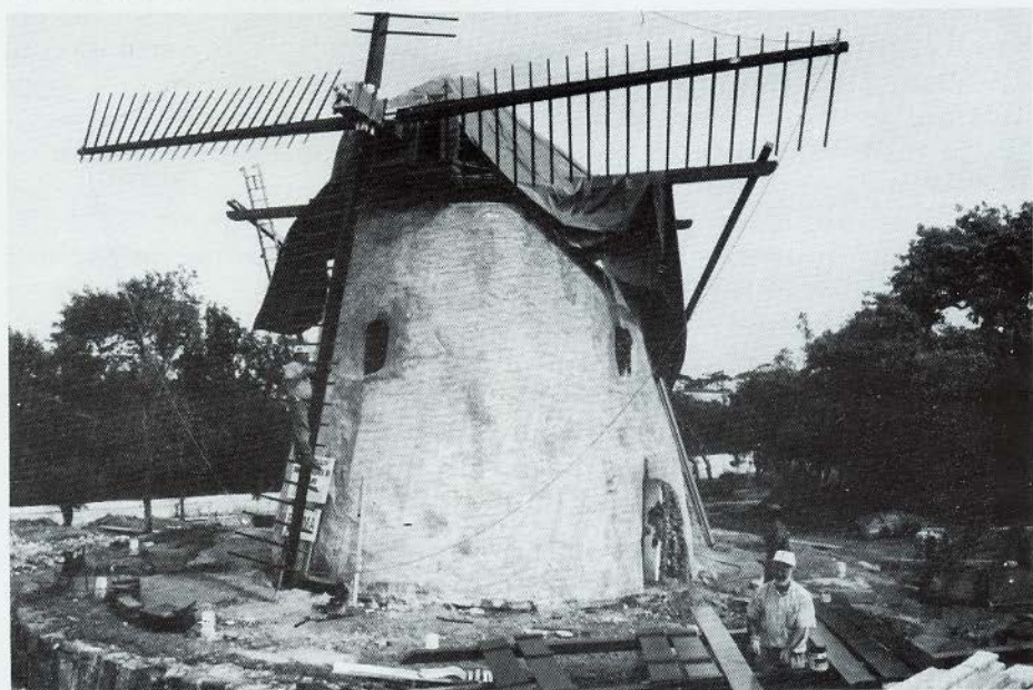
Eltjo Faber bezig met het opzetten van de kluften, Henk Dunning aan het verven. MOSTERT SE MEUL, Kaapstad (foto: C. Westers, 16-10-95)
