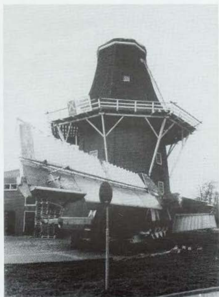
Koren- en pelmolen DE LEEUW te Oldehove. De kap met de complete binnenroede staat op de grond. (foto: MEvD, 29-04-96)
