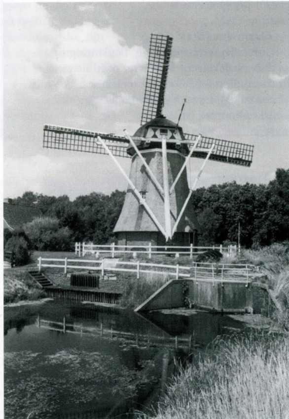
De poldermolen van de polder Wedermarke nabij Wedderbergen. De omgeving, onder andere gevormd door het hekwerk beïnvloedt zowel het zicht op de molen als de windvang.
