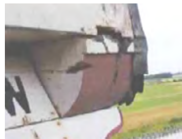
Voeghout, rechtgetrokken met spanner Voeghoutkop ingerot
